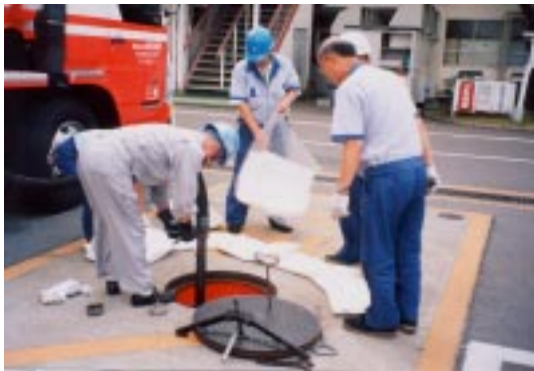
石油販売会社と共同で行われた燃料油漏洩緊急事態対応訓練
