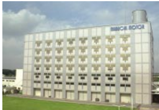
蛍光灯の安定器交換を行ったテクニカルセンター
