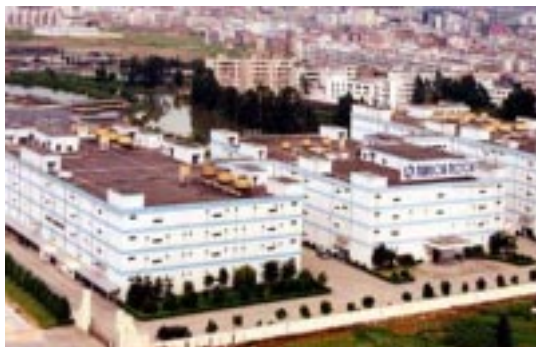
マブチモーターは常に省エネルギーを念頭に新工場を建設しています。写真は広島マブチ第一工場の新社屋、最新の省エネルギー技術を数多く取り入れています
