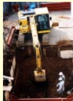
汚染された土壌の掘削
