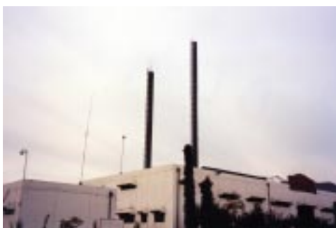
大連マブチのボイラー室。省エネ型ボイラーと新型脱硫機能付き集塵機を導入しています
