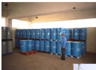
洗浄液を含む化学物質を保管するために建設された防滲、防爆機能付き専用倉庫（江蘇マブチ）
