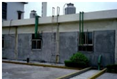
エアコンプレッサルームに防音壁を増築（江蘇マブチ）
