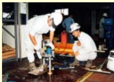
構内土壌調査
