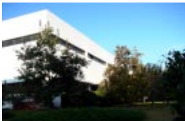
緑に囲まれている大連マブチの工場棟
