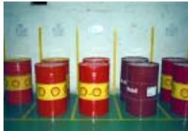
液漏れ防止のコーティングをした床（大連マプチ）
