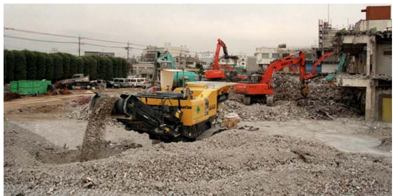
解体廃材の粉砕、選別
