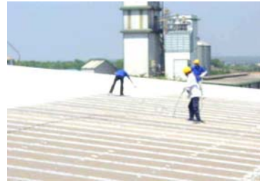
ベトナムマブチの工場屋根に断熱塗装工事(2004年実施)。
