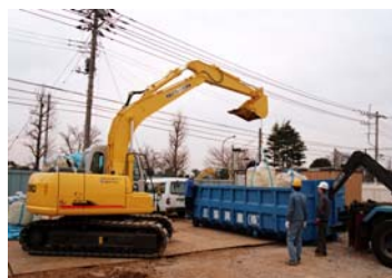
リサイクルされる解体廃材の出荷
