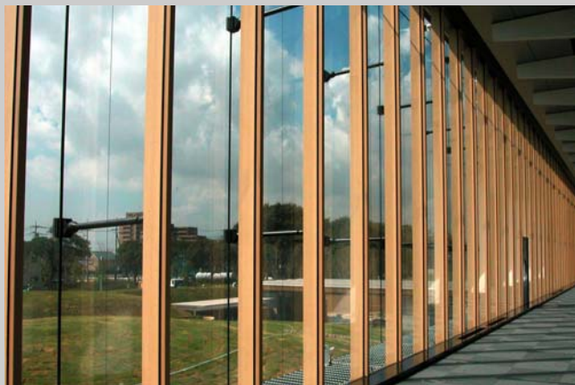
上図:ダブルスキン内部に生じる煙突効果による排熱促進のほか、アトリウムトップライトと連携し、中間期や夜間において、自然換気により空調負荷を低減する 左図:ダブルスキンからの自然採光を有効に活用し、照明電力を削減します。
