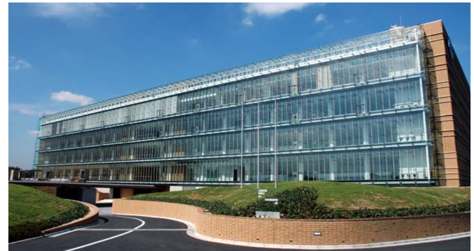
サステナブル建築賞を受賞したマブチモーター松戸本社ビル
