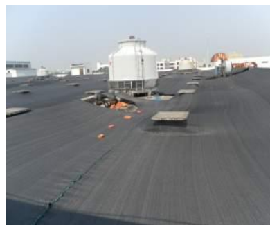
工場屋上に遮熱工事を実施し、夏 期の室内温度が工事前より36%低 下、空調電力使用量を大幅に削減 (江蘇マブチ)
