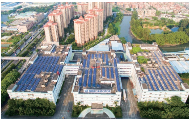
道ジャオマブチ屋上の太陽光発電パネル
