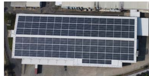
ダナンマブチに設置された太陽光発電システム
