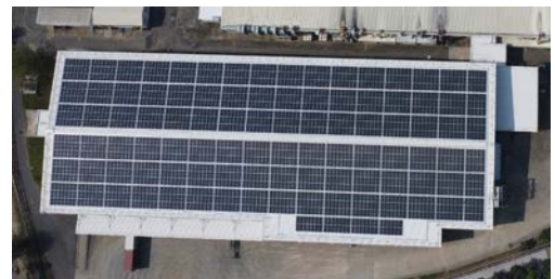
ダナンマブチに設置された太陽光発電システム
