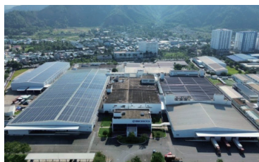
ダナンマブチの太陽光発電システム
